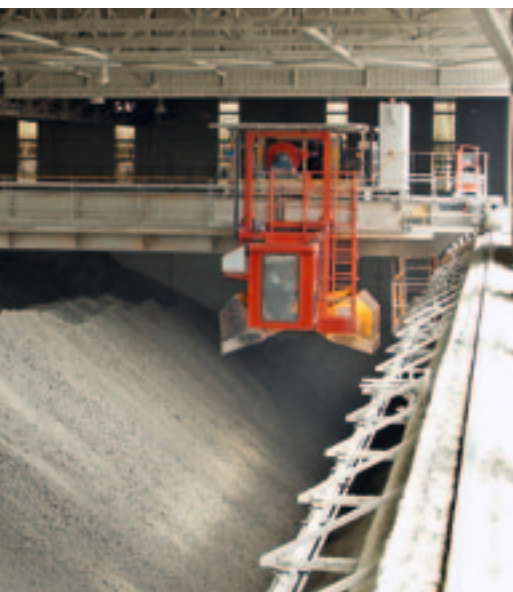
↑ Lagerung und Homogenisierung in der Schotterhalle.
