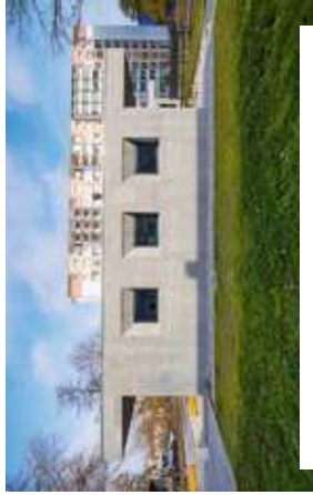
Infralichtbeton ermöglicht eine monolithische Bauweise, bei der ein einziges Material den Lastabtrag wie auch die wärmedämmende Funktion übernimmt.
