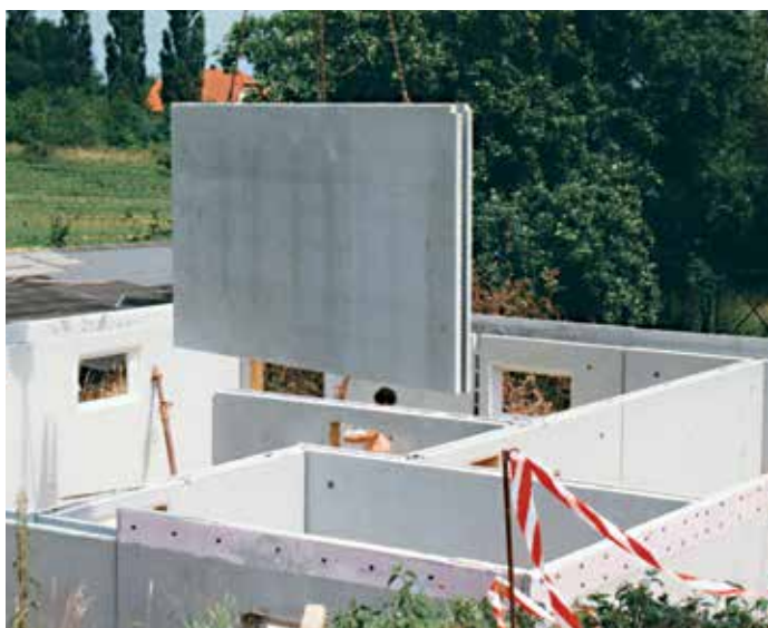
↓ Versetzen mit Kran
