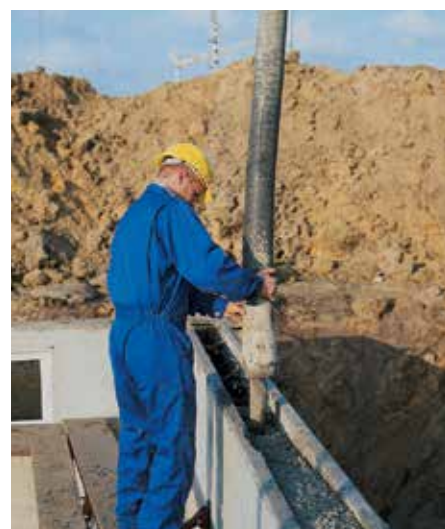
↑ Betonage der Doppelwand
