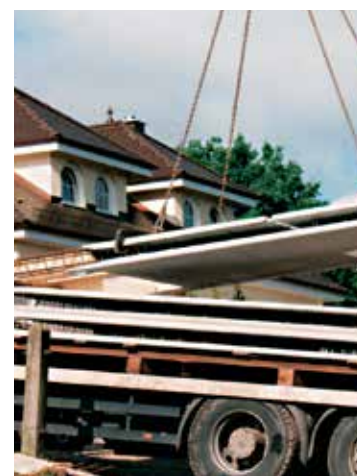
↑ Anlieferung und Montage
