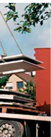
↓ Versetzen mit Kran
