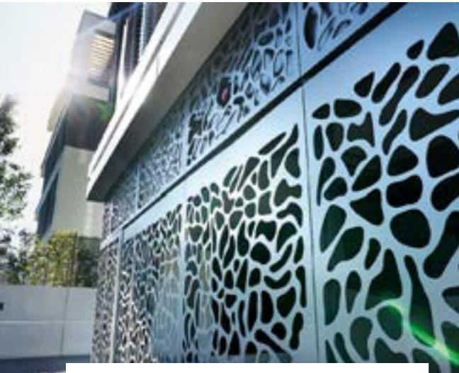
Klare Linien, hochwertige Materialien und plakative Strukturen schaffen eine lebendige Fassade.
