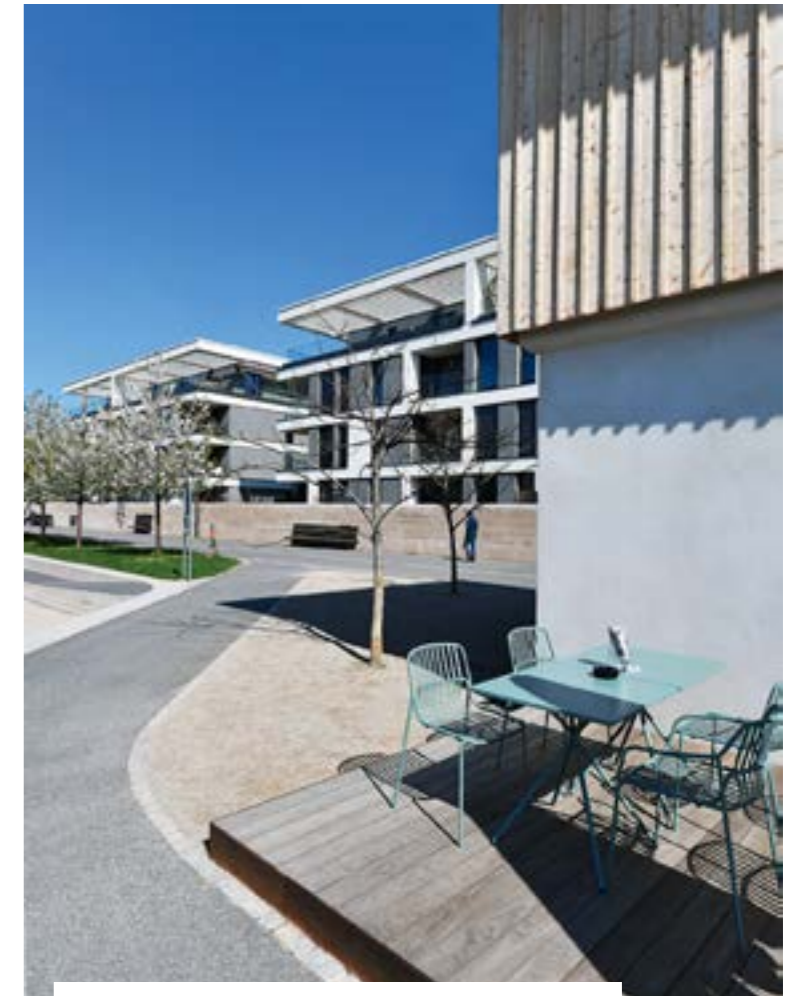
Auf Terrassen, Loggien und Balkonen lässt sich das Leben in der Passivhausssiedlung genießen.
