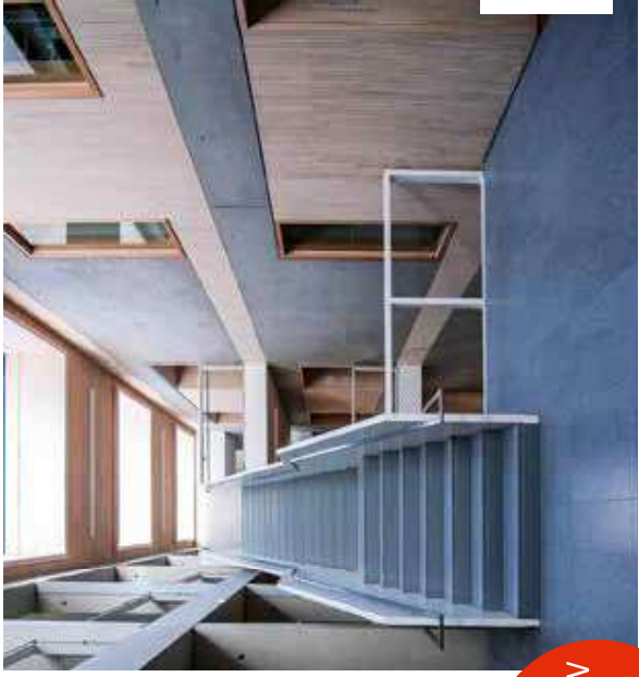
Die Ausführung der vor Ort betonierten Wände und Stützen erfolgte in Sichtbeton der Klassen 3 und 4.
