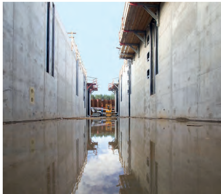
↑ Überlaufbauwerk Cottbusser Seen
