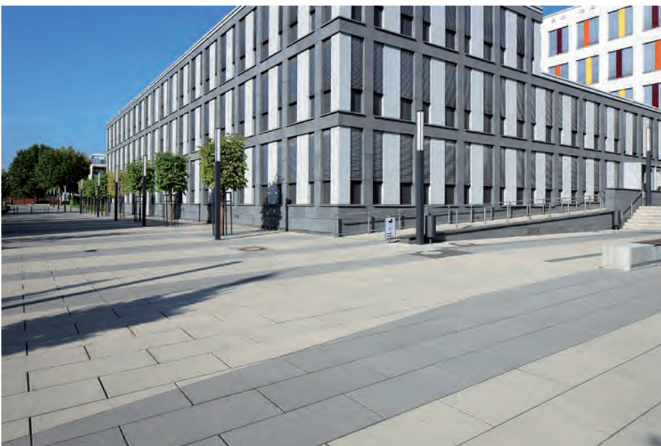
← Justiz- und Verwaltungszentrum, Wiesbaden, KSP Jürgen Engel Architekten GmbH
