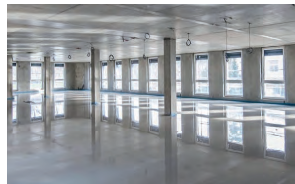
HeidelbergCement Technology Center, Leimen ↑ HHS Planer + Architekten AG, Kassel
