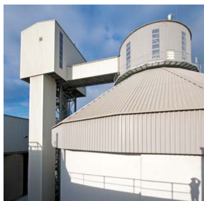
← In Silos werden die Erzeugnisse des Brennpzesses, der Zementklinker, gelagert.
